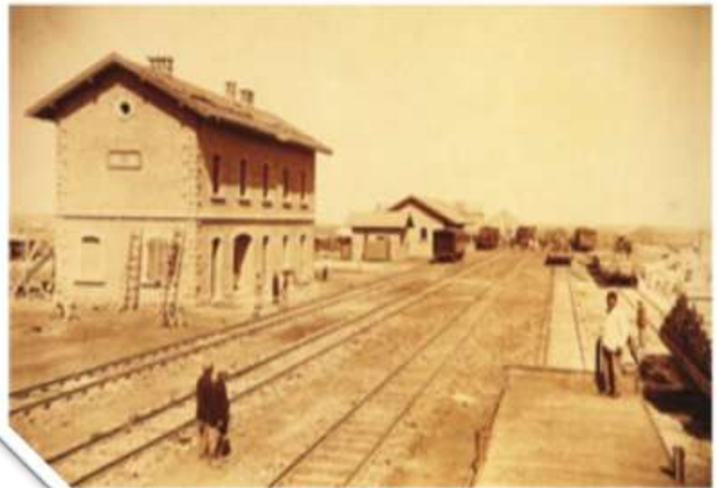
en.1a1en محطة درعا قيد الإنشاء 1903
